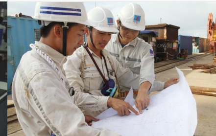
Triển khai thi công tại hiện trường
