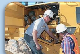
Sửa chữa, bảo trì hệ thống
