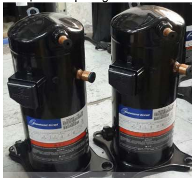
Hình 3. Máy nén Scroll của hệ thống VRV
