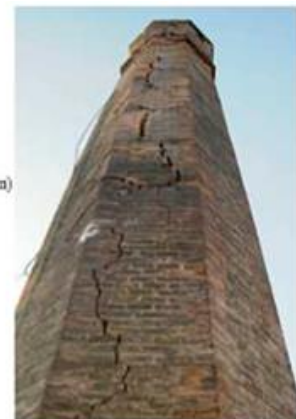
Hỏng hóc ống khói do ứng suất nhiệt
