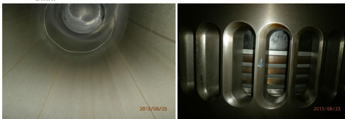
Hình 11: Kiểm tra quan sát trạng thái kỹ thuật thực tế của từng xi-lanh
